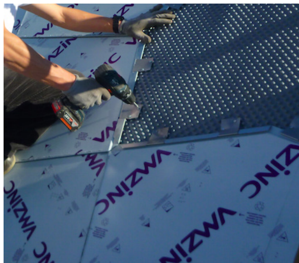
Installationsbillede af skræddersyede femkantede shingles.
